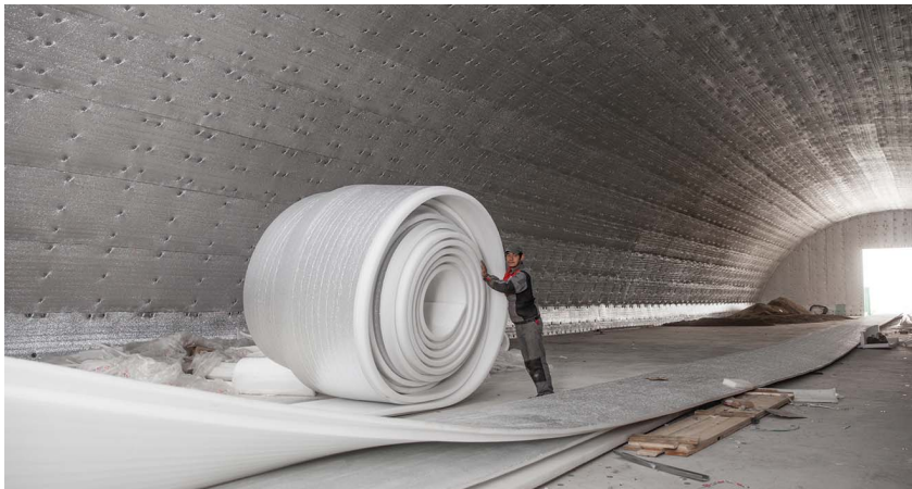
Рис. 2. Подготовка рулона из металлизированного вспененного полиэтилена
